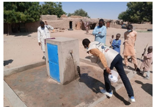
Réception d'une borne fontaine construite dans le cadre du projet à Gueskerou, région de Diffa
