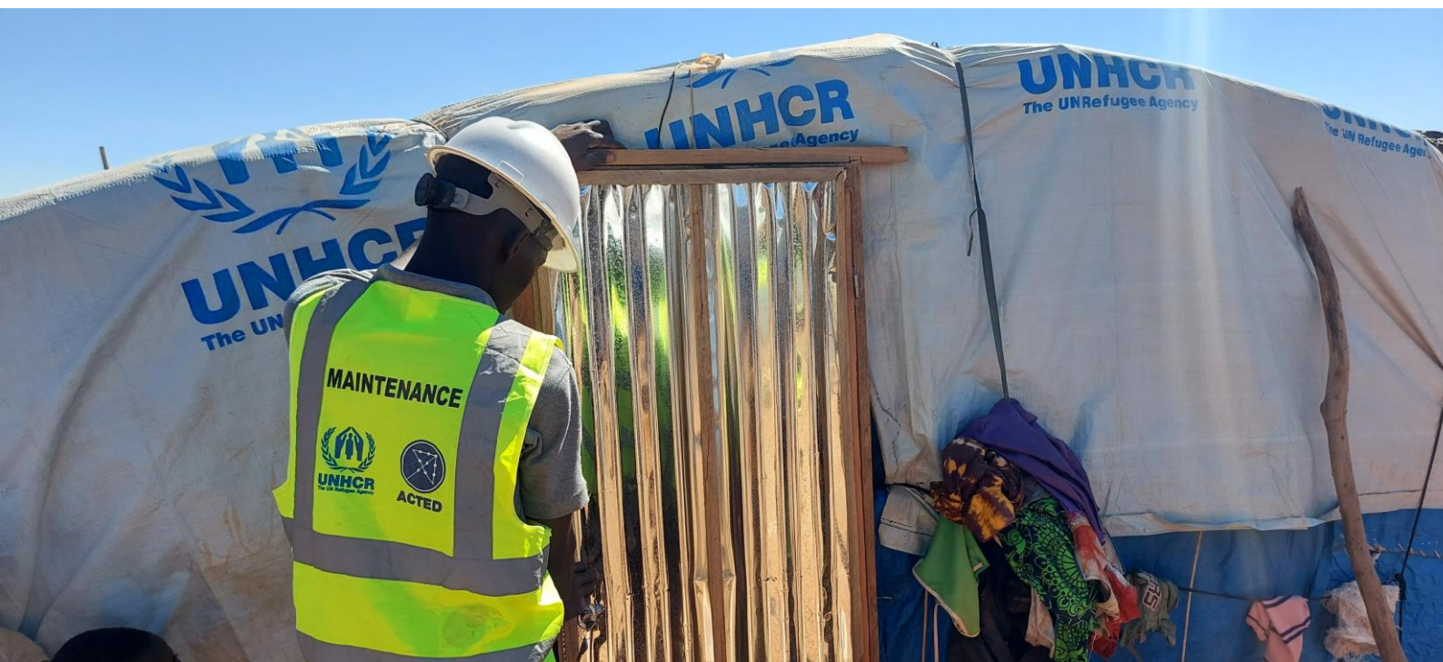
Installation d'une porte sur un abri d'urgence dans le cadre d'activités de maintenance de site, Centre-Nord, novembre 2021.
