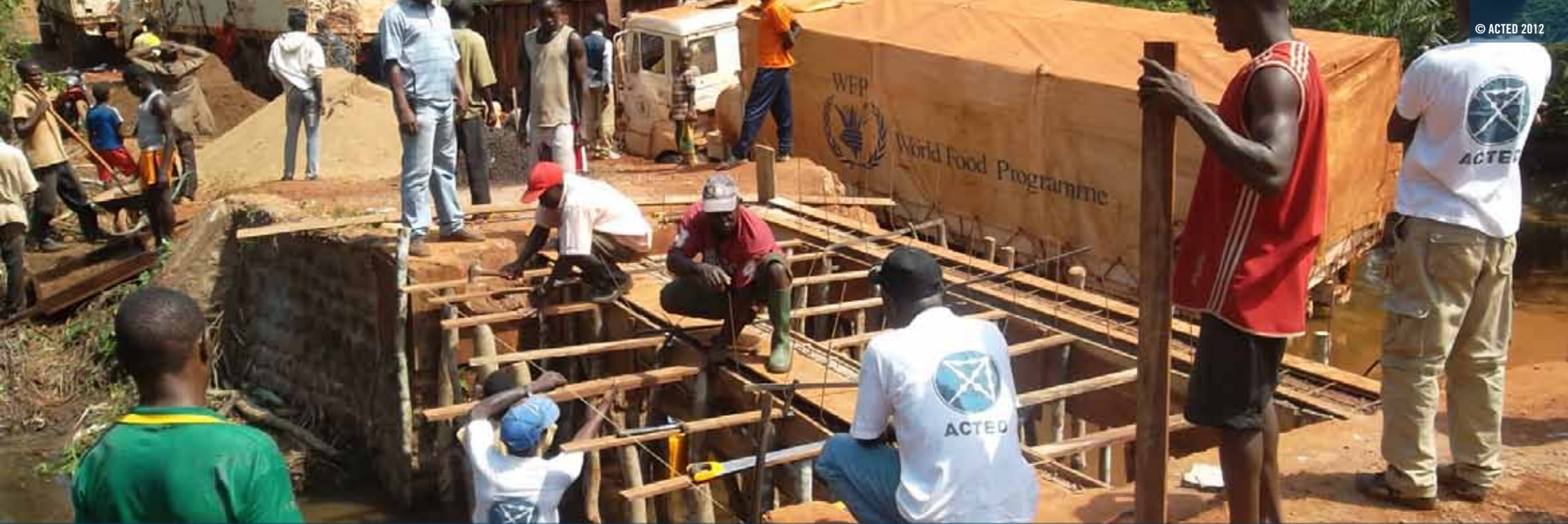
ACTED's mobile brigade rehabilitates a bridge on the Bangassou-Zemio axis (South-East) to improve local living conditions. Une brigade mobile d'ACTED réhabilite un pont situé sur l'axe Bangassou-Zemio (sud-est), pour améliorer les conditions de vie.
