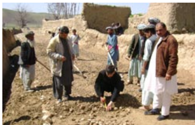
Rehabilitation works of a community access road / Travaux de réhabilitation d'une route d'accès secondaire © ACTED 2007
