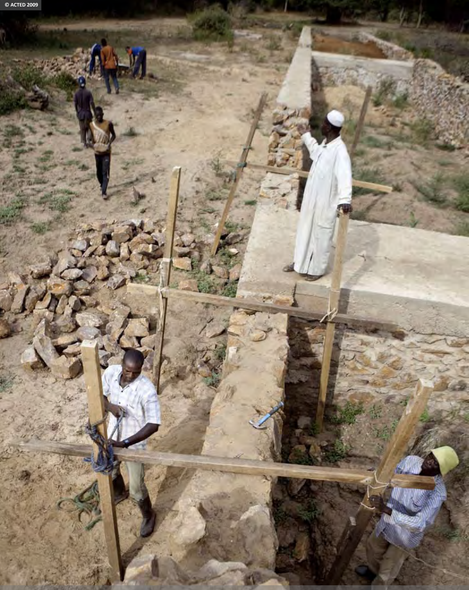
Culvert construction nearby Djourlo on the road from Louboutiké to Kerfi (Chad) / Construction d'un dalot à Djourlo sur l'axe Louboutiké-Kerfi (Tchad)
