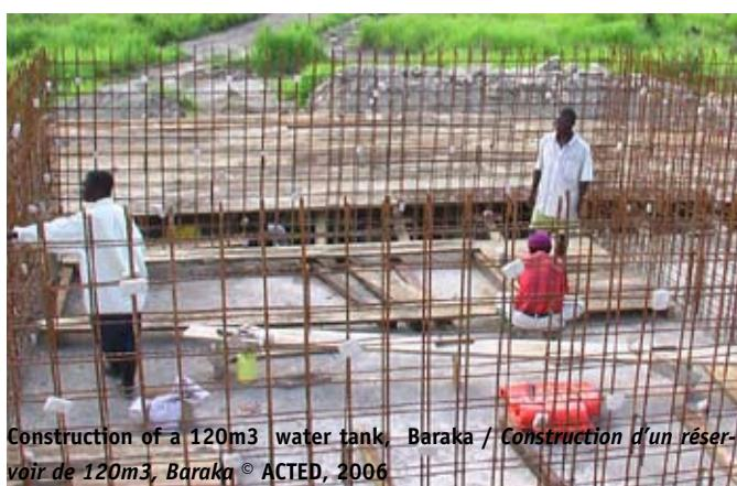
Construction of a 120m<sup>3</sup> water tank, Baraka / Construction d'un réservoir de 120m<sup>3</sup>, Baraka © ACTED, 2006
